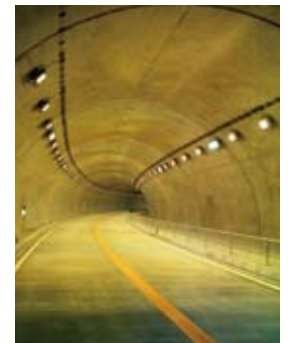
トンネル照明
