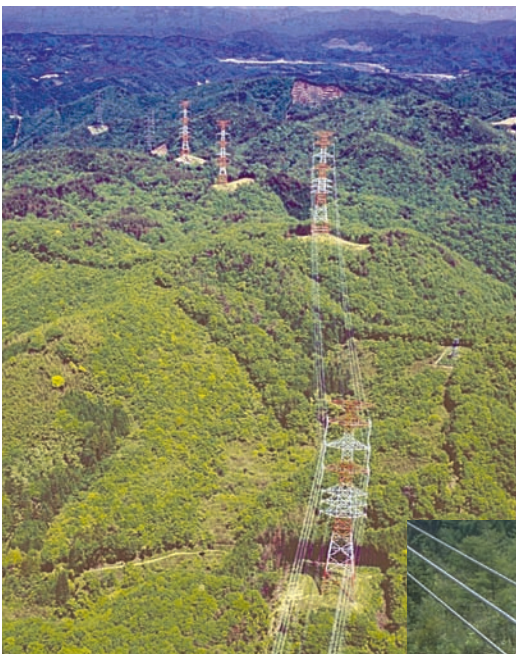
山の中の送電鉄塔
