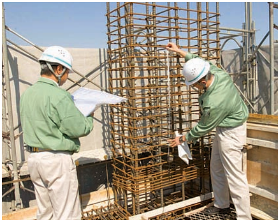
サーパスマンションの施工風景
