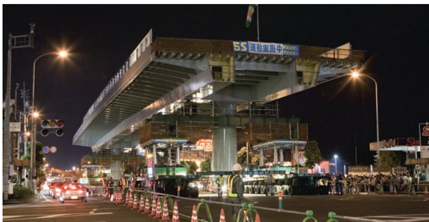
国道11号線小坂交差点立体工事 作業風景
