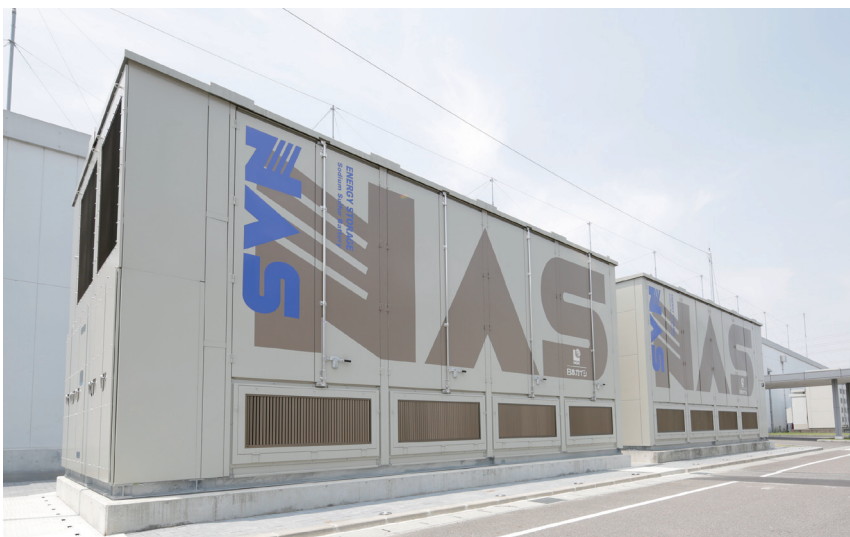
↑NAS電池は、Na(ナトリウム)とS(硫黄)を電極とする蓄電池。2つの電極を隔てる中間層となる電解質は、ナトリウムイオンの伝導性を持つベータアルミナセラミックスで作られている。
